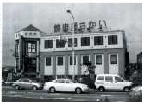
焼肉の海軍に翻じた店舗「オーダーシステム」の正味。特に現場は海水浴場である。
